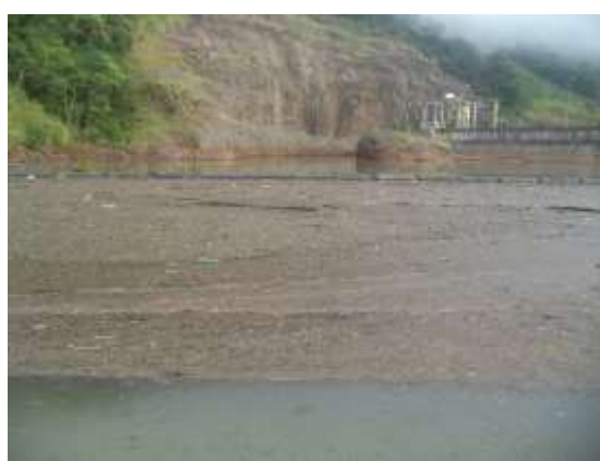
Foto 1 – Material orgânico acumulado no reservatório junto ao barramento, com presença de macrófitas (Macrófitas 1).
