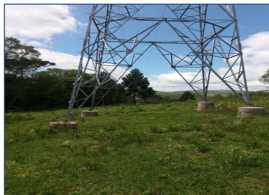
Base de uma torre da Linha de Transmissão. Fonte: ABG.
