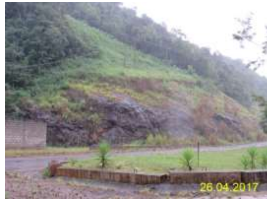
Foto 2 - Situação atual no Ponto 10. Vistoria realizada em 26/04/2017.
