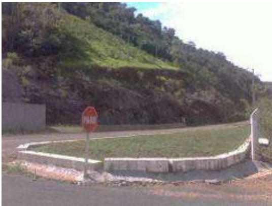
Foto 1 - Situação Inicial do Ponto 10. Vistoria realizada em 10/05/2010.
