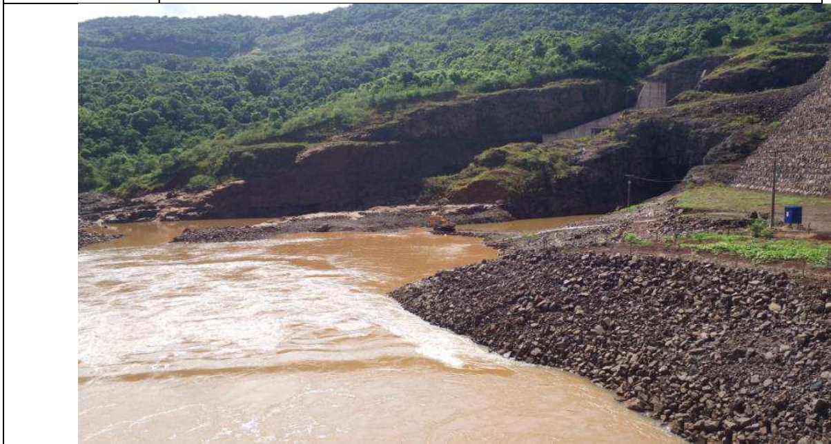
Foto 02 - Também foi feito um rebaixo junto a antiga passagem molhada para evitar o aprisionamento de peixes no antigo túnel de desvio do rio Passo Fundo.
