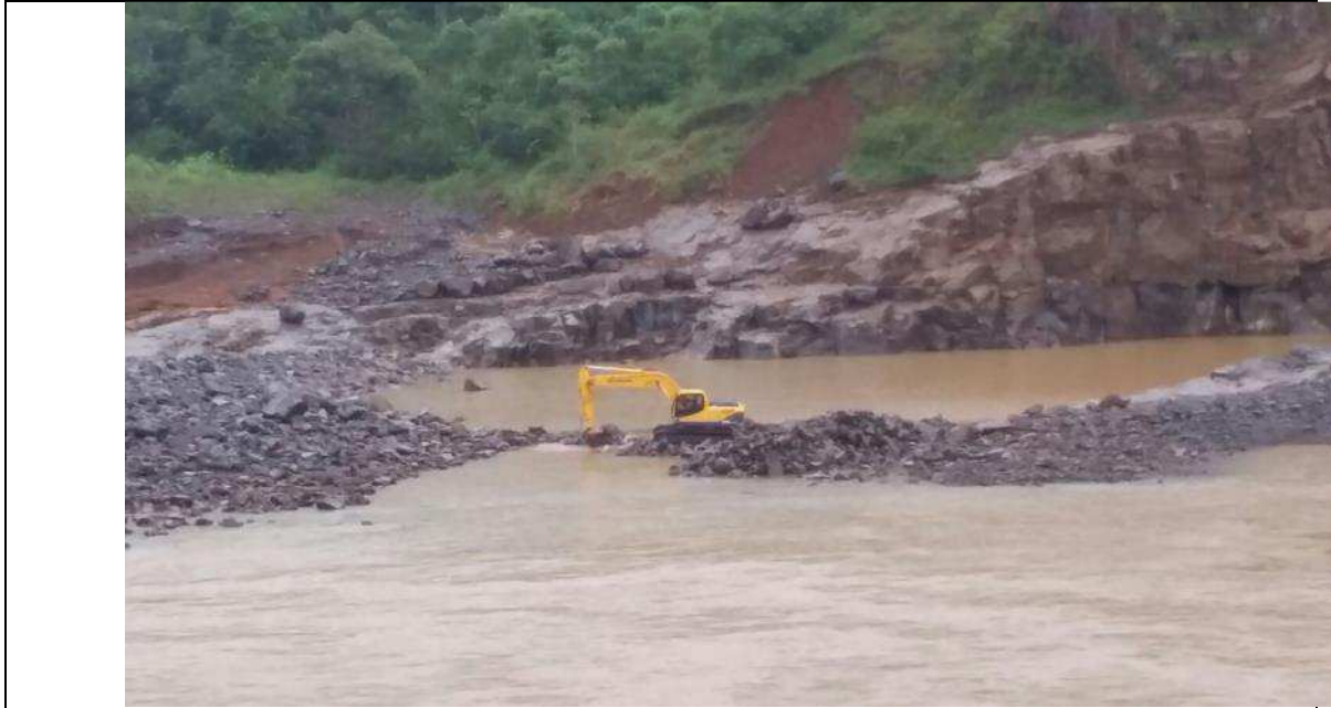
Foto 01 - Abertura de um canal para comunicação do vertedouro com o Rio Passo fundo para evitar o encalhe de peixes fevereiro de 2016.
