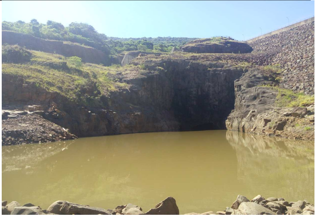
Foto 03 – Canal do túnel do antigo de desvio do rio Passo Fundo que deve ser utilizado para aterro com material rochoso disposto no leito do rio.
