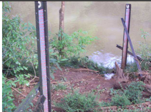
Foto 4: Réguas de referência para o sensor de nível da estação automática telemétrica Cruzaltense Montante, em out/13.
