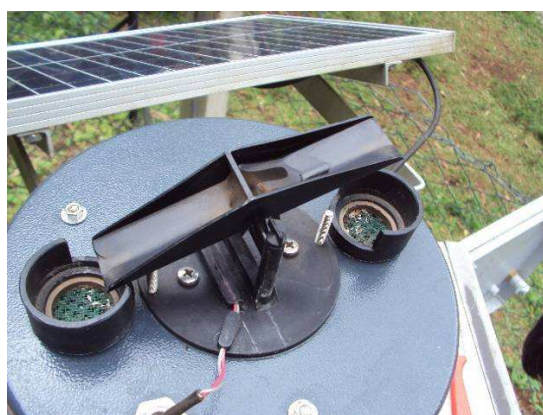
Foto 2: Manutenção e limpeza do pluviômetro da estação automática telemétrica Entre Rios Montante, em out/13.
