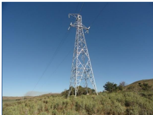
Vista de uma torre de Linha de Transmissão. Fonte: ABG.
