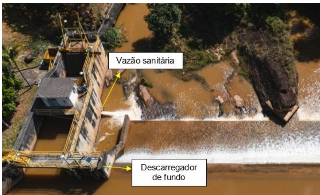
Imagem 2 – Vazão sanitária e descarregador de fundo
