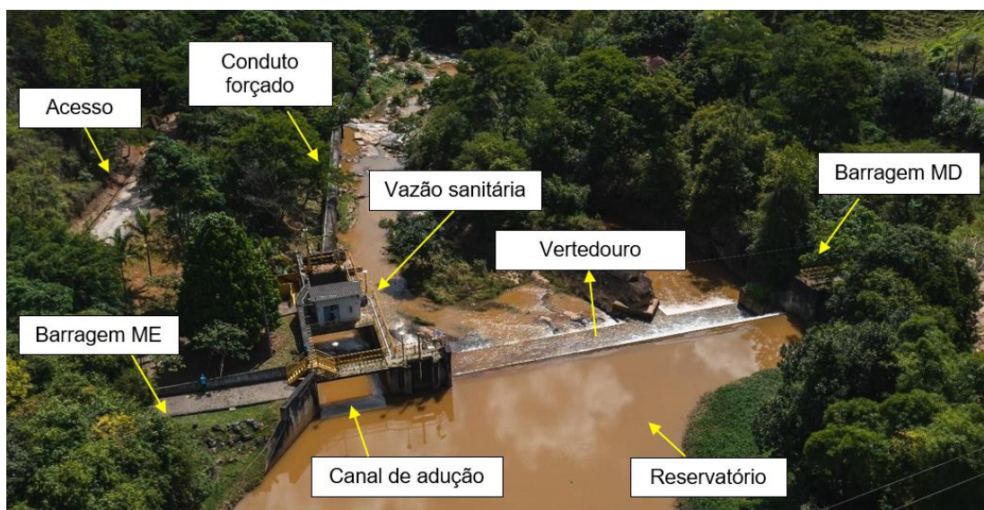
Imagem 1 – Arranjo geral da barragem
