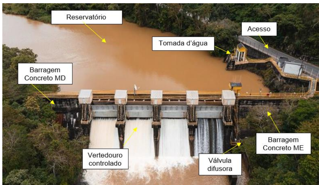
Imagem 1 – Arranjo geral da barragem
