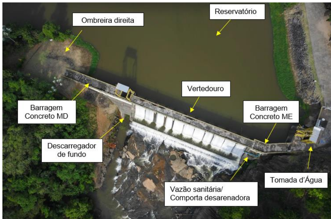
Imagem 1 – Arranjo geral da barragem
