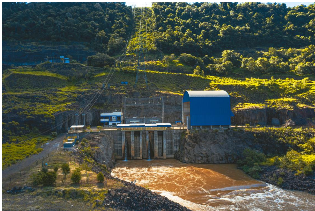
Imagem 2 – Saída do canal de fuga
