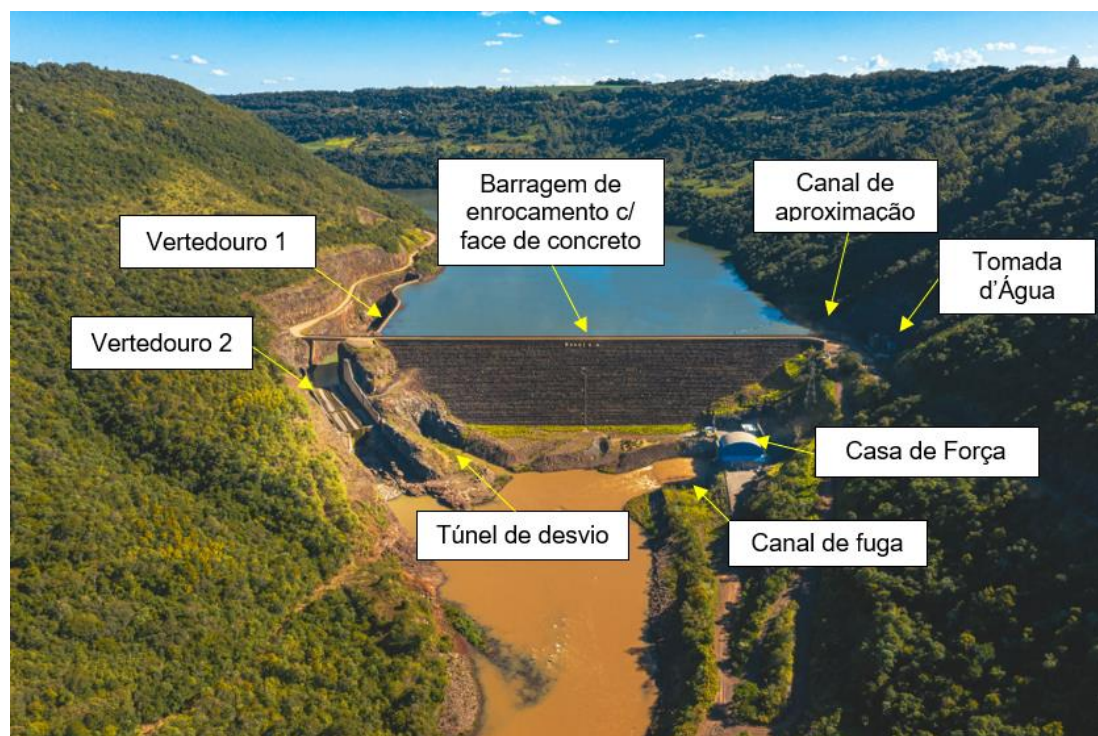
Imagem 1 – Arranjo geral da barragem
