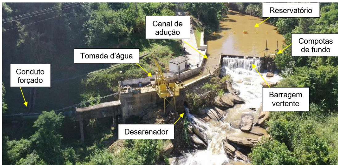
Imagem 1 – Arranjo geral da barragem
