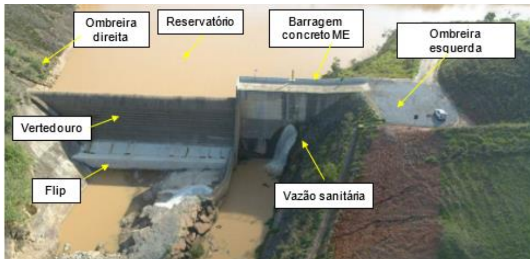
Imagem 3 – Arranjo geral da barragem de geração
