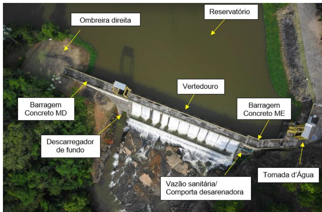
Imagem 1 – Arranjo geral da barragem
