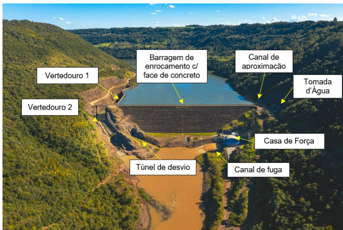
Imagem 1 – Arranjo geral da barragem
