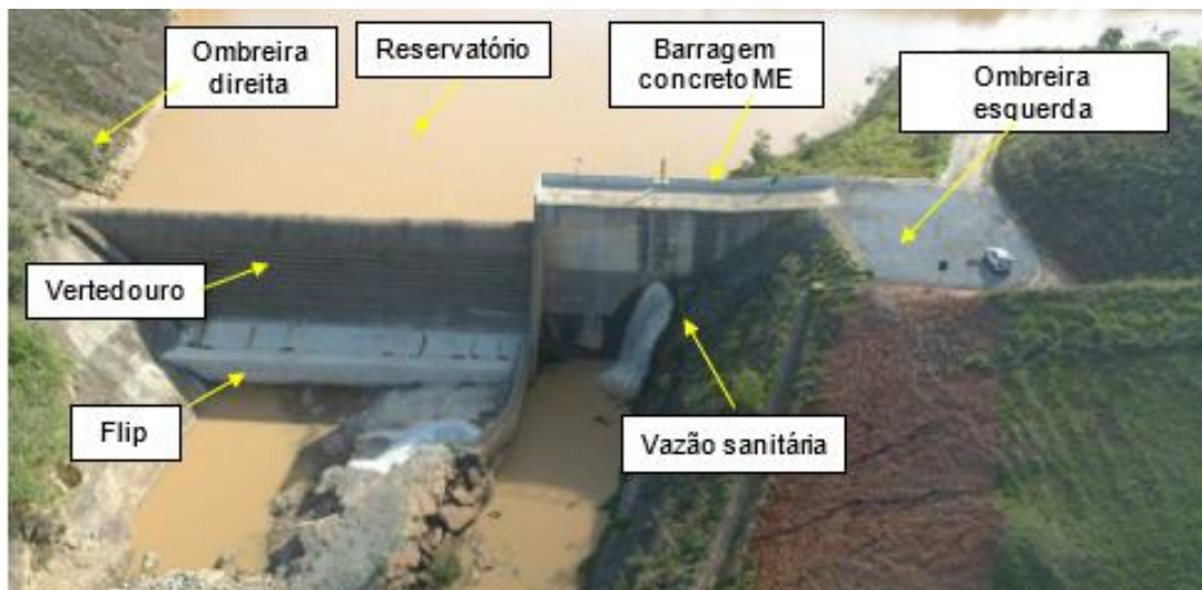
Imagem 3 – Arranjo geral da barragem de geração
