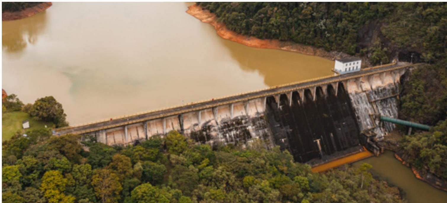
PCH está instalada no Rio Santa Maria da Vitória, originando um reservatório com 2,2 km<sup>2</sup> de área. A usina conta com uma potência instalada de 22,50 MW.
